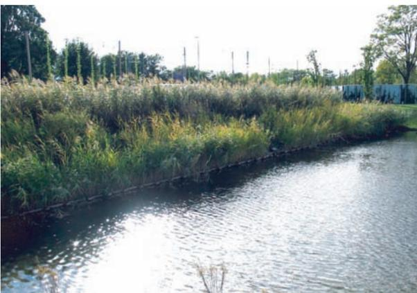
Bodenfilter mit Schiffbewuchs
